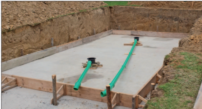
Vorbereitung zum Bau einer Pool-Bodenplatte.
